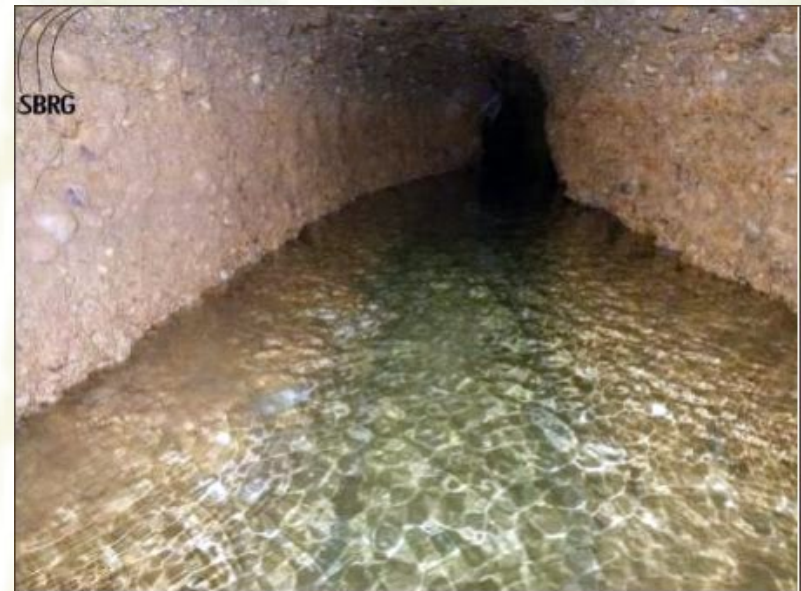
Dans les tunnels de l'eau:
